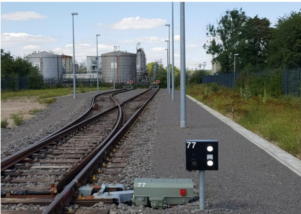
Im Gleisbereich des Terminals werden die LS Signale 61X bis 65X sowie das LS Signal W70X automatisch in Stellung Hp0 „Halt“ gestellt. An der Fahrwegstelltafel (FT 2) werden alle Sperrmelder aktiviert. Die örtliche Bedienung der Anlage ist nicht mehr möglich.
