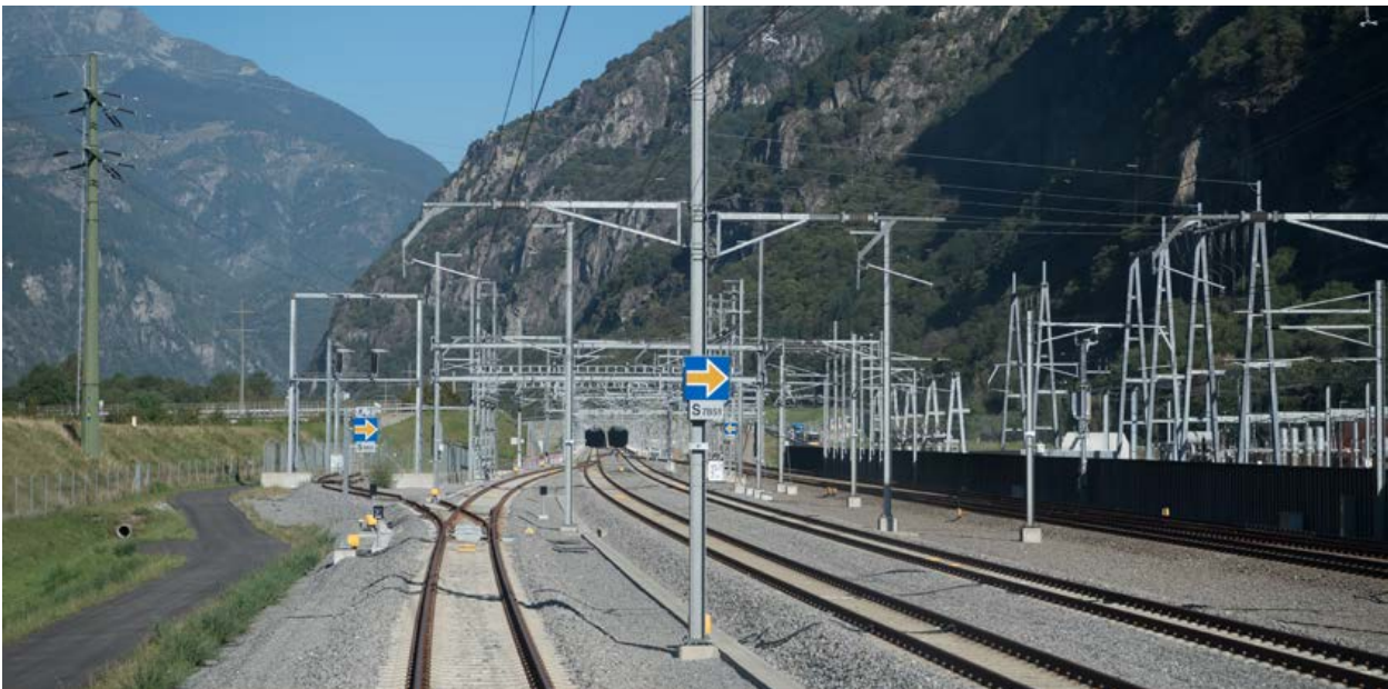
Ore 9.53: La torre dà il via libera e il viaggio riprende attraverso l'opera svizzera del secolo.
