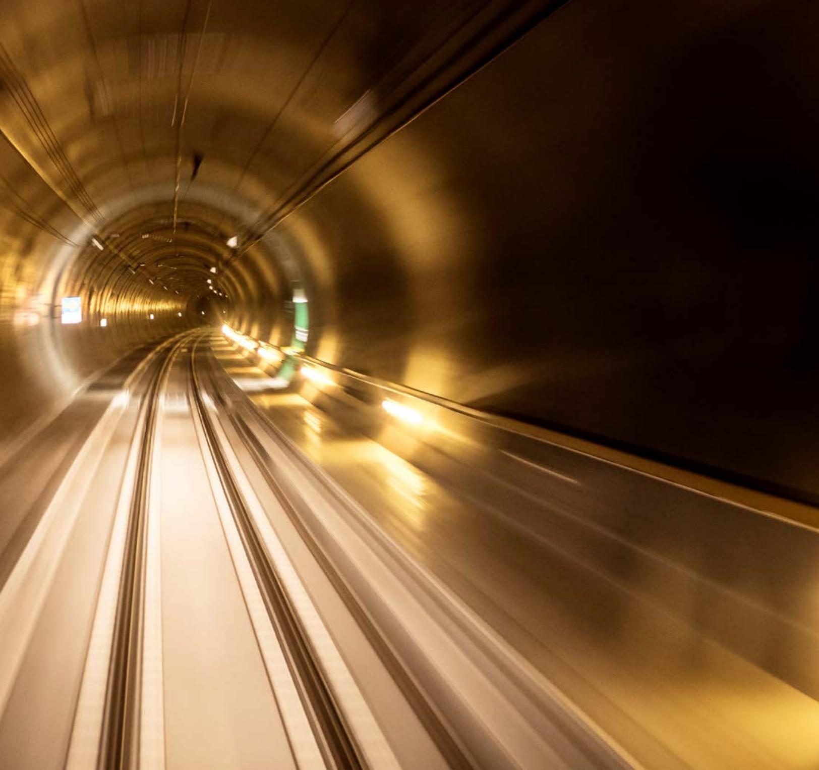
*10.15 Uhr: Beeindruckend: Mit konstanten 100 Stundenkilometern fährt der Zug durch den flachen Tunnel. Im Gegensatz zu Personenzügen bleibt die Geschwindigkeit für Güterzüge auf dieses Tempo beschränkt, weil die Bahnwagen für dieses Fahrtempo gebaut und zugelassen sind.*
