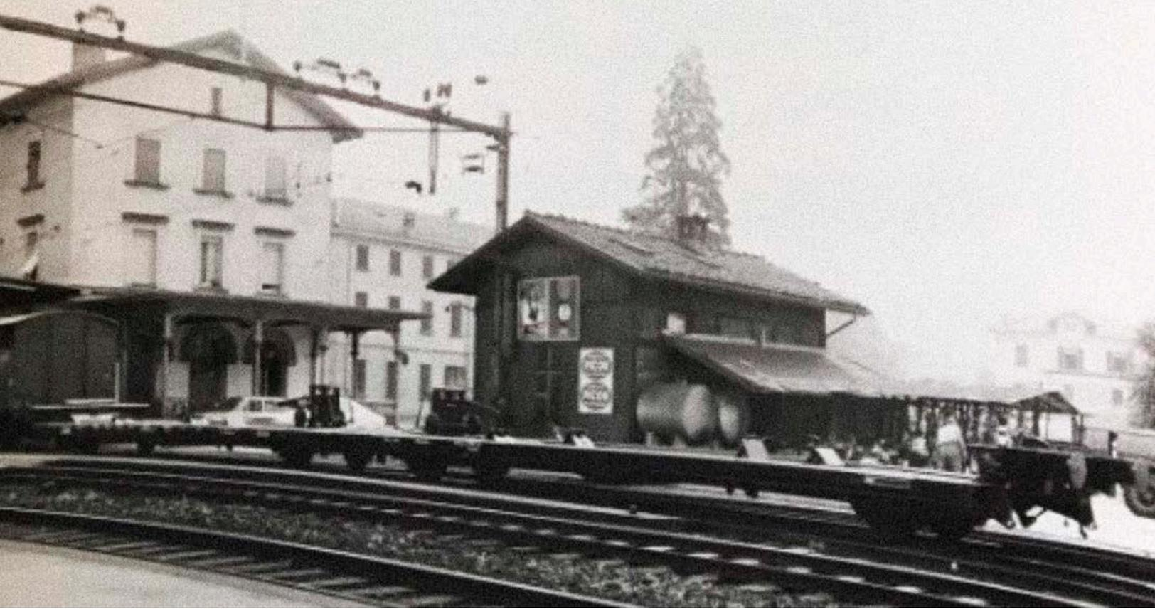
*1968, 2. Juli: Die ersten Wagen der Hupac im Bahnhof von Giubiasco bei Bellinzona. Es handelt sich um zweiachsige Wippenwagen. Die zu verladenden Sattelanhänger werden horizontal von einer Zugmaschine in die richtige Position gezogen. Dabei wird die federbelastete Ladefläche durch die Gewichtskraft des Sattelauflegers nach unten gedrückt (Wippe). Die Wagen wurden bei der Deutschen Bahn angemietet, in Erwartung der Auslieferung der Wagen, die bei Ferriere Cattaneo bestellt worden waren.*
